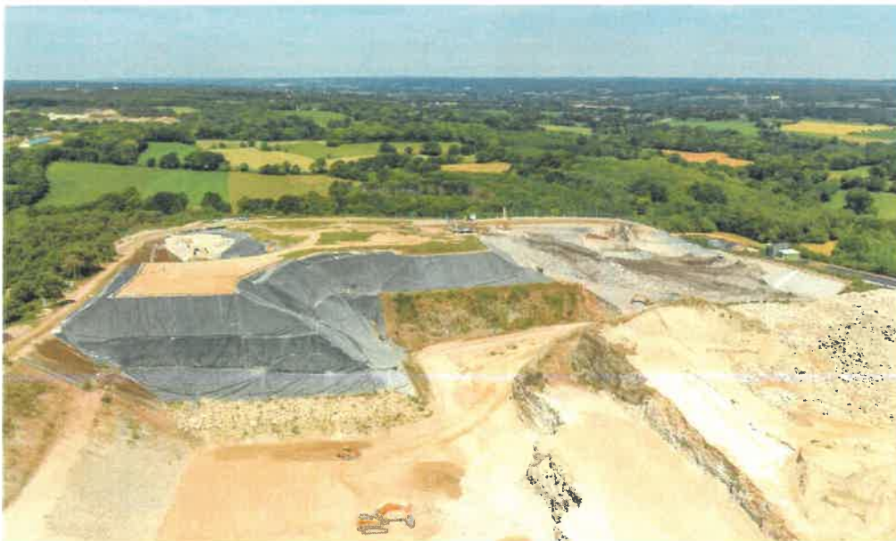
Vue générale confinement de l'ISDND
